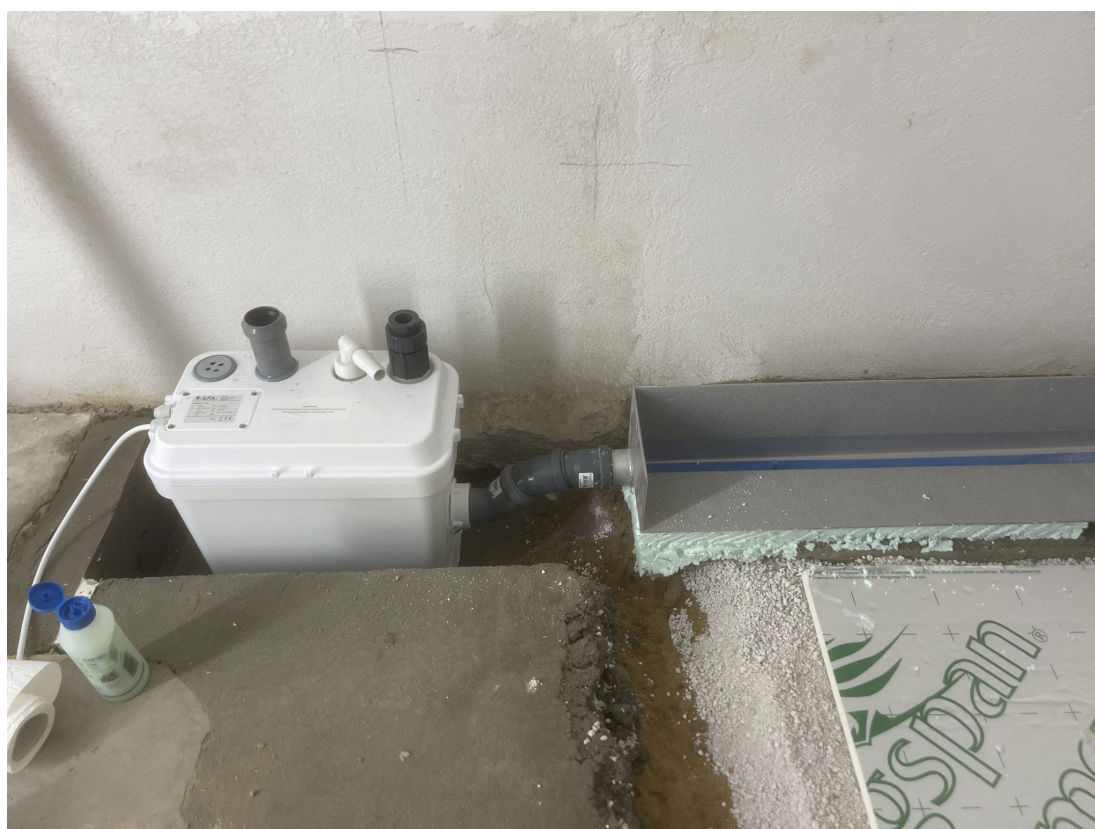
Montagezustand: vollständige Einbausituation mit Hebeanlage, DN-50-Verbindung und maßgefertigter Duschrinne.
