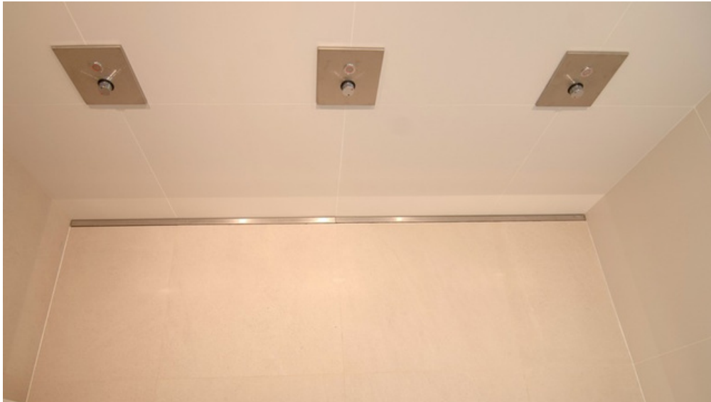
Einbau der Duschrinne von Wand zu Wand
