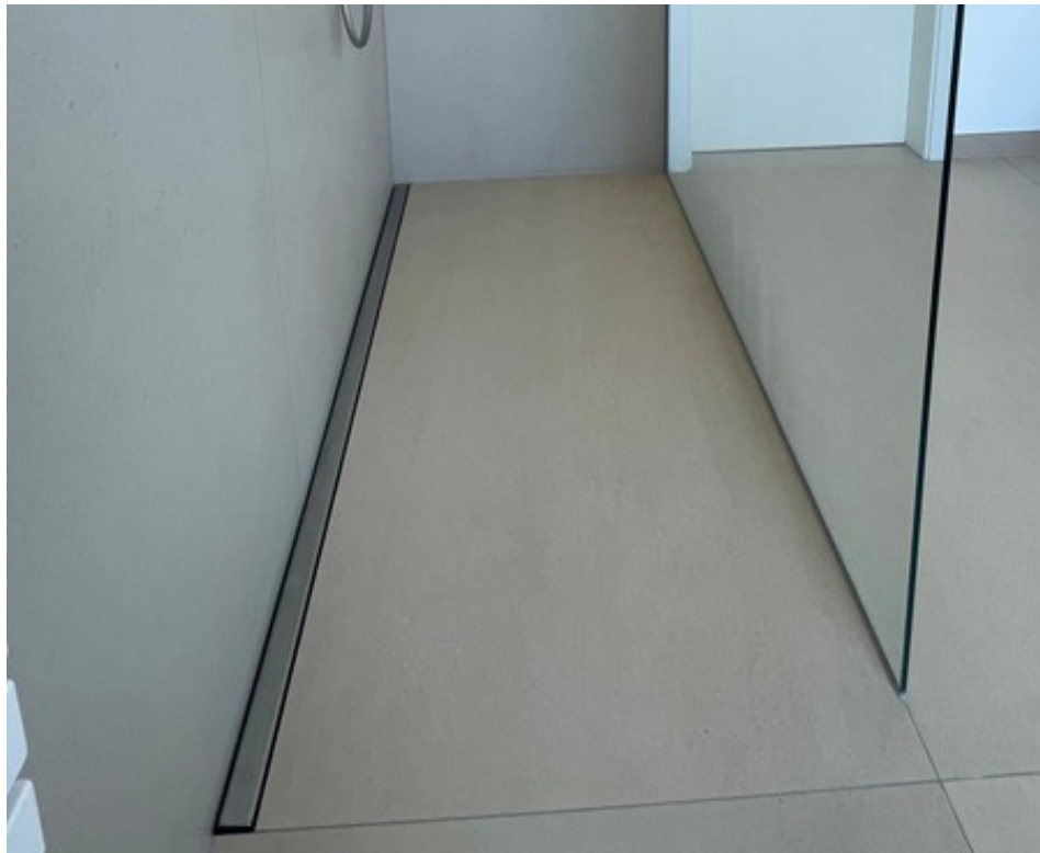
Einbau der Duschrinne auf der langen Seite, um eine ebenerdige Dusche im Obergeschoss zu realisieren
